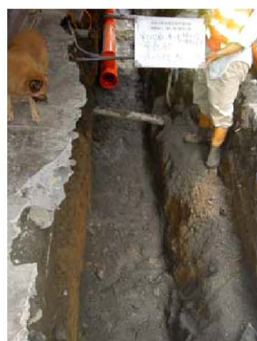
回填底砂及埋設連接管
