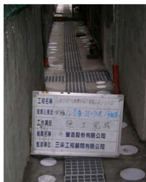
後巷水溝蓋板鋪設
