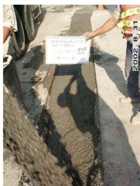
澆置低強度混凝土 或級配
