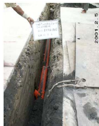
回填底砂及埋設連接管
