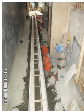
後巷水溝組立模板
