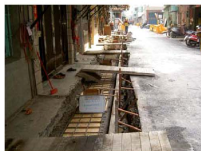
水溝模版及鋼筋彎紮
