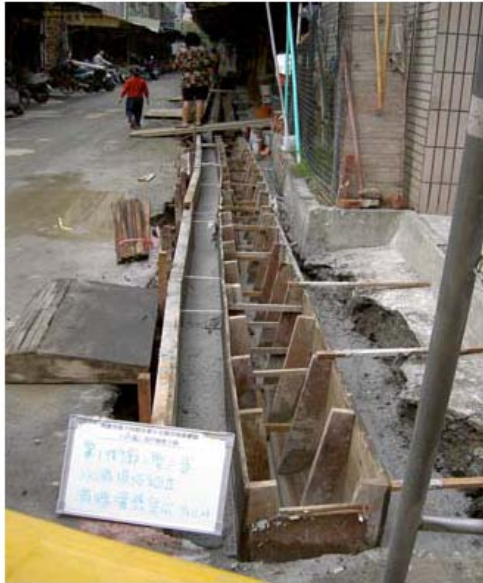
水溝側牆灌注混凝土
