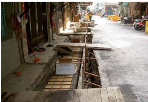
水溝頂版模版及鋼筋
