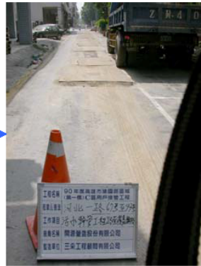
鋪設臨時鋼板
