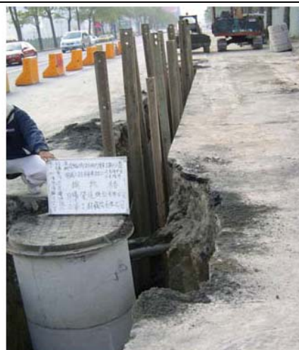
陰井框蓋裝設
