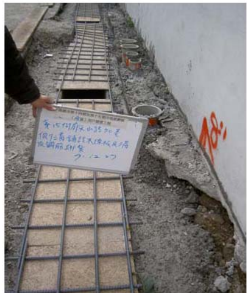
水溝頂模及紮筋
