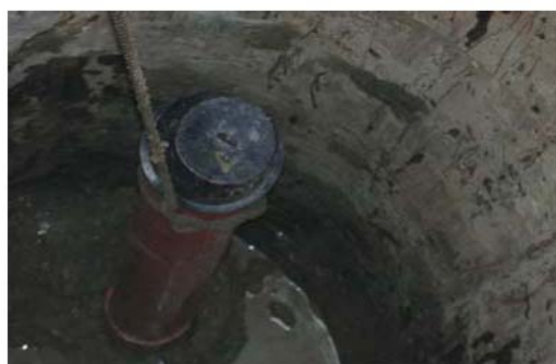
深開挖外跌落管施工
