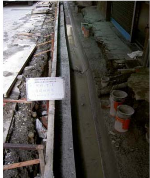
水溝側牆拆模
