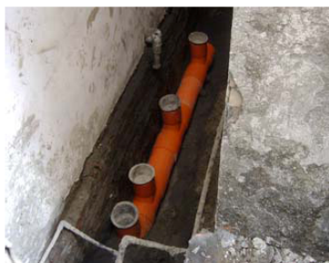
後巷連接管及順T接頭位置
