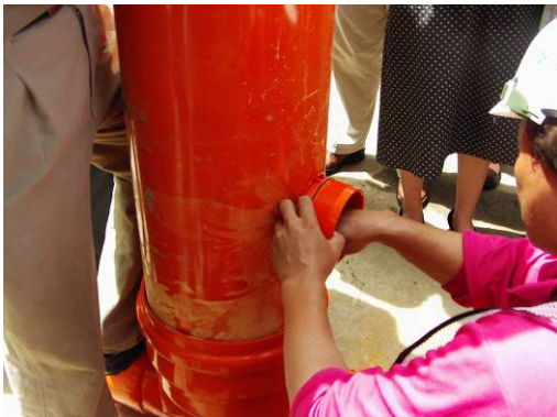
直管接續器安裝(1)
