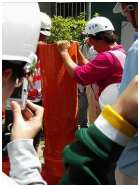
§ 300mm 組件及連接井立管安裝
