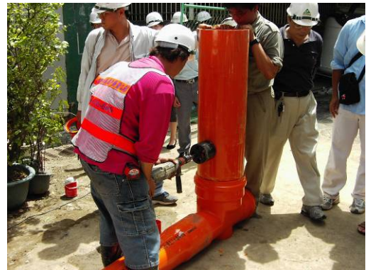
組件及連接井立管切削器開孔
