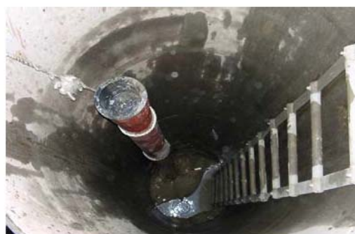
內跌落管施工
