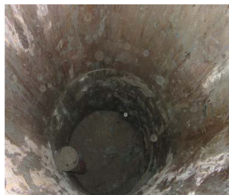
鋼套環內施作外跌落管
