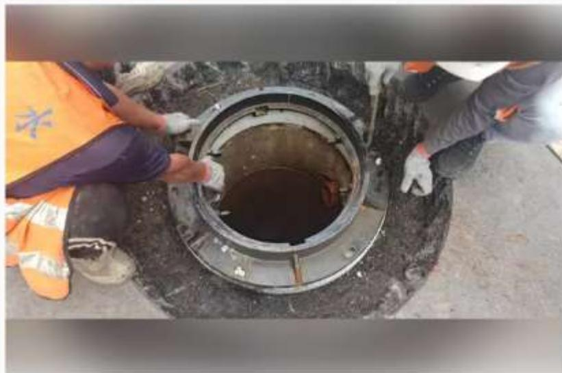
工作人員正在更換耐揚壓框蓋，避免人孔蓋因為壓力關係彈出傷及旁人。圖／北市衛工處提供
