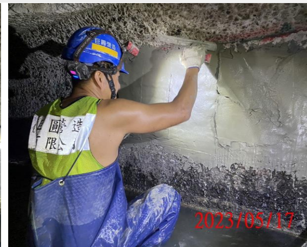
TYPE C 局部混凝土破損
