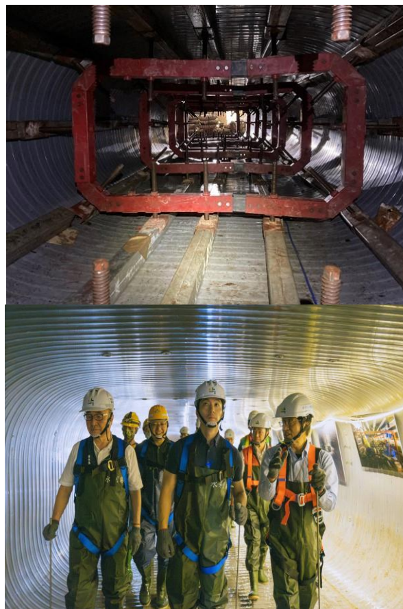
螺旋內襯(SPR)工法
