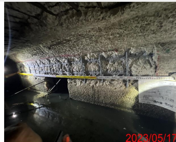
TYPE C 局部混凝土破損
