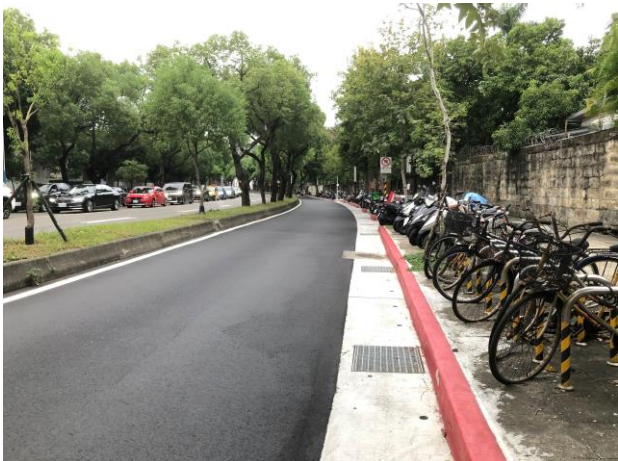
中山北路5段排水改善工程 過去該路段雨水僅靠側進式進水孔排入系統，路面逕流排放效益較差
