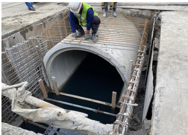
延平北路8段157巷排水改善 系統管徑1.2m 改為2.0m
