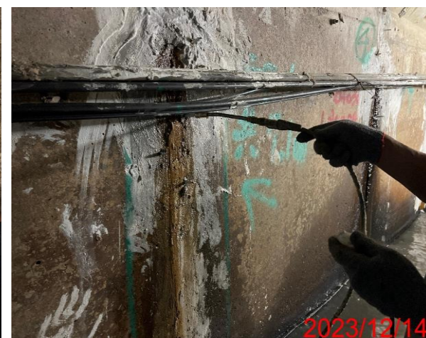
TYPE E 局部滲水裂縫
