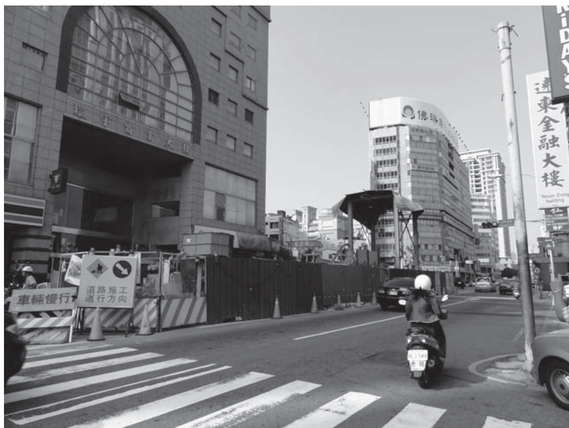
照片-5 YASUDA ENGINEERING (ヤスダエンジニアリング株) 之施工全景
