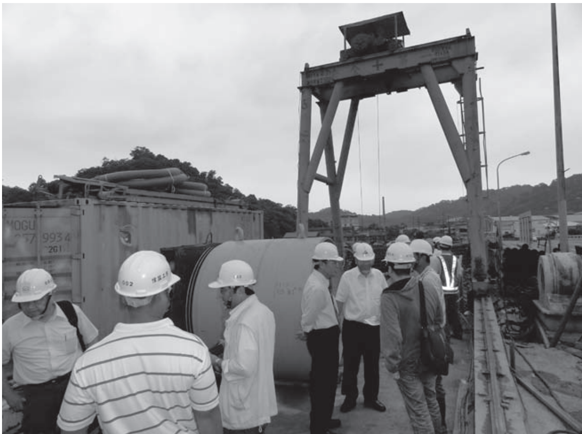
照片-23 機動建設工業(株)施工中之工事現場
