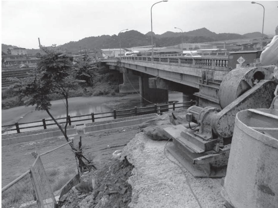
照片-24 即將開始穿越河川部分之工程
