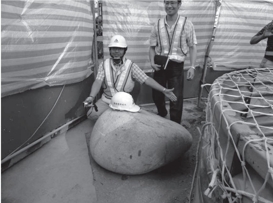
照片-8 工作井開挖時挖掘出之巨大卵石
