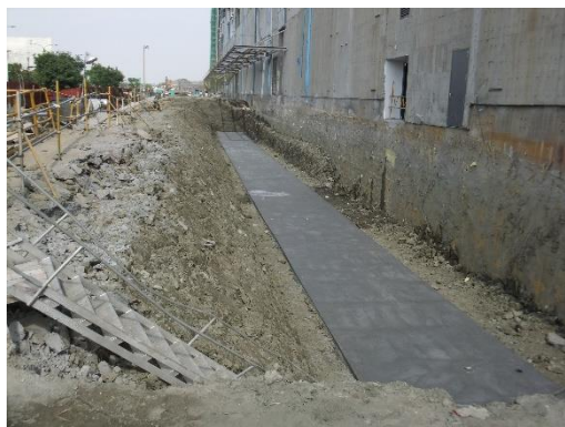
① 開挖及基礎鋪設
