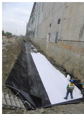
② 底面地工合成材料鋪設
