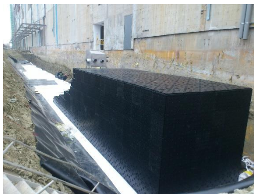
④ 貯留結構體組裝
