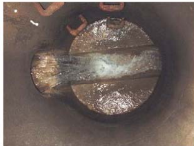
圖-2 實際的人孔內部（常用的外跌落管）
