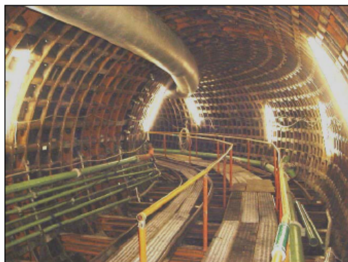
超急曲線 (8mR) 施工狀況
