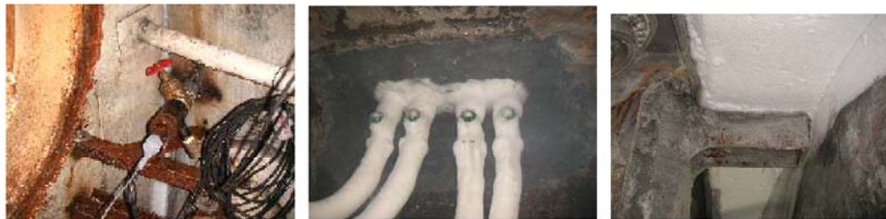
照片五 測溫管之配置及土艙內冷凍情形
