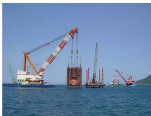
照片二 到達井鋼構吊放情況
