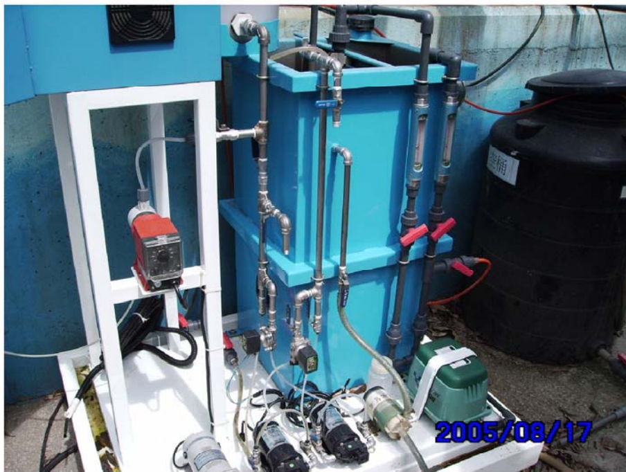
圖 2 MBR 模廠外觀 (從左至右：PLC 控制器、薄膜槽、進流桶)
