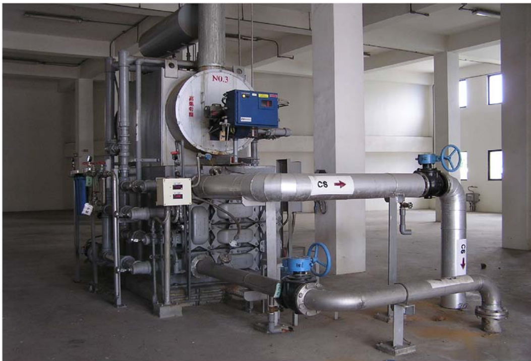
圖 6 污泥熱交換器照片
